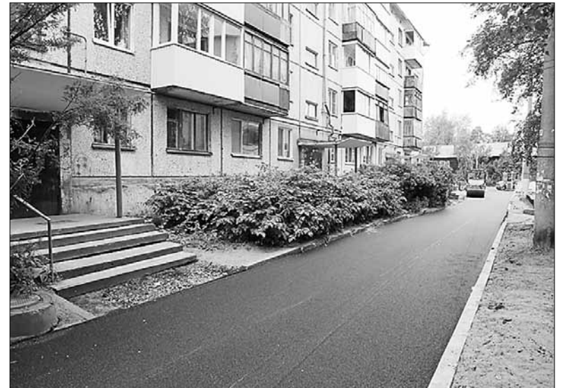
■ В этом году активно ремонтировались дворовые и межквартальные проезды
