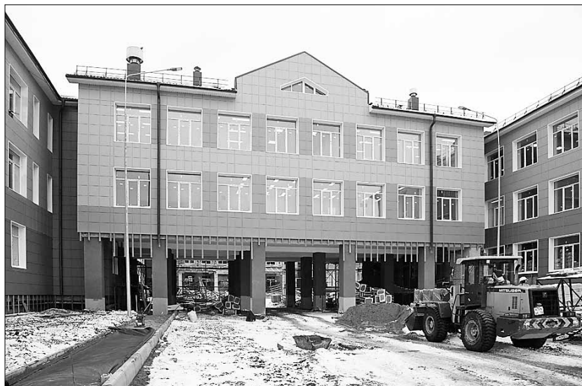
■ В округе Варавино-Фактория продолжается строительство современной школы на 860 мест
